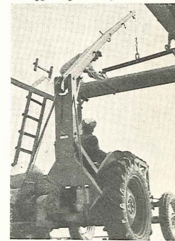
Krankrog på læsseapparatets løftearme. Traktor med kranarm arbejdende på etageadskillelse. Løfteevne 600 kg. Spillet trækkes fra kraftudtaget og udlægget reguleres hydraulisk.
