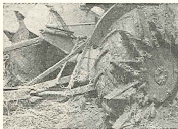
Stålskovblade til formindskelse af hjulslip.
